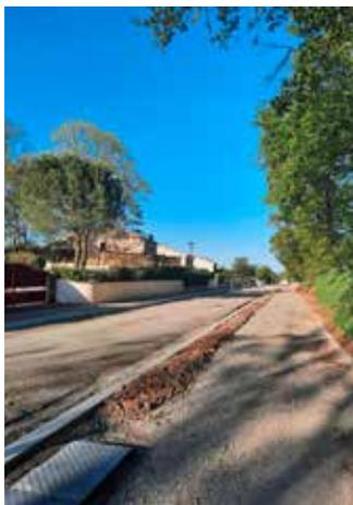
La pose des bordures délimitant les nouveaux espaces (trottoirs, voie mixte, écluses) s'est réalisée après la reprise des travaux d'assainissement tels que des reprises de branchements et de remise à la cote de regards.
