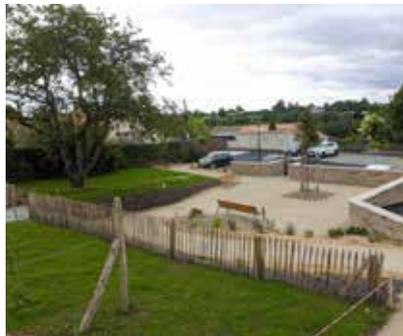
La mise en place des différents revêtements a été réalisée avec un traitement en sable calcaire sur les cheminements et la placette et en enrobé sur les voiries adaptées aux véhicules légers. Après une période nécessaire de non-utilisation, les stationnements enherbés vont être disponibles dans les prochains jours. Les diverses plantations ont été réalisées avec la présence d'arbres, d'arbustes, de vivaces... venant requalifier et aérer cet espace au cœur du quartier de l'industrie.
