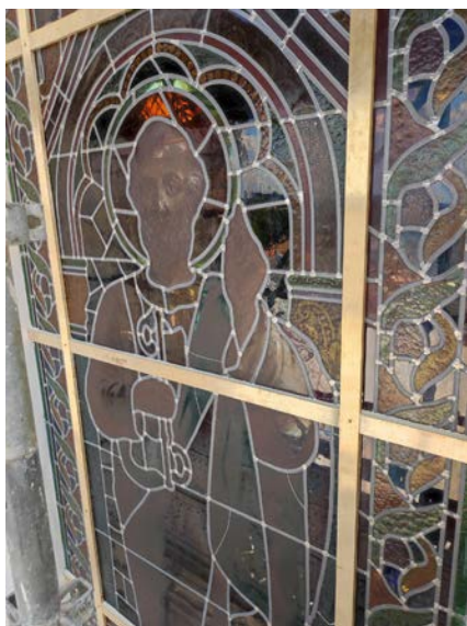
Vitrail après repose (Vue extérieure)
