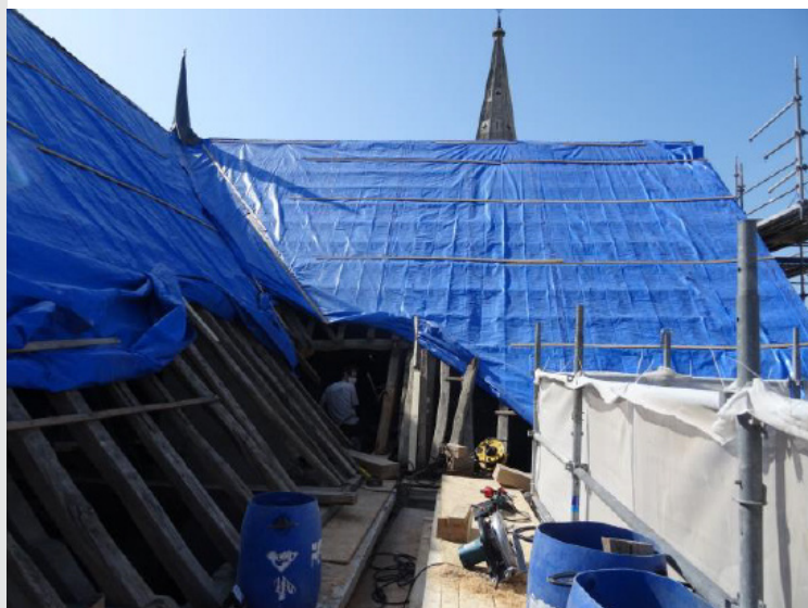
Travaux en cours sur le retour de transept et sur une partie du chevet
