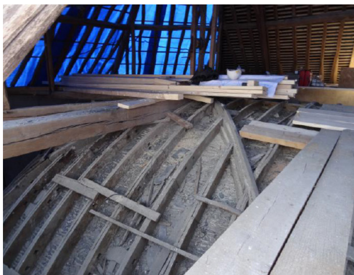
Reprise de la charpente
