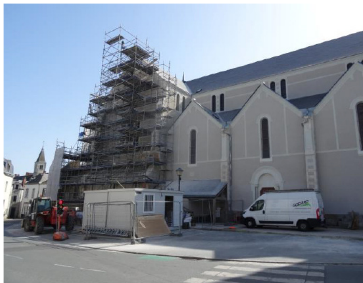
La façade nord est terminée
