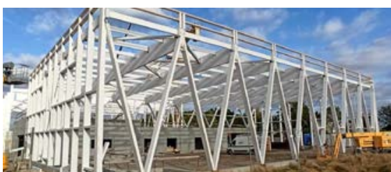
Charpente salle de gym
