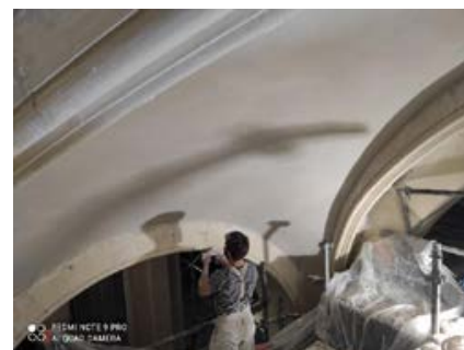
Voûte en cours de finition
