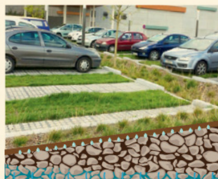
Parking en dalles-gazon et dalles-pavés
