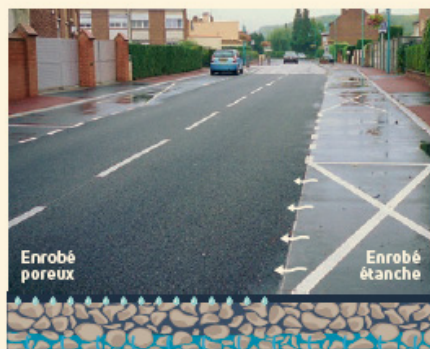
Chaussée à structure réservoir
