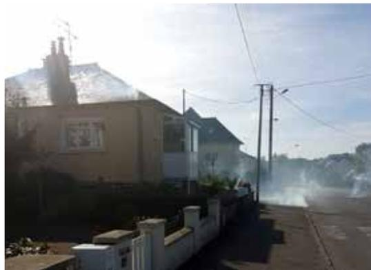
Cette opération (pour les inspections fumigènes) consiste à insuffler de la fumée dans le réseau d'assainissement d'eaux usées de la rue (sur domaine public ou servitudes privées), afin de contrôler la nature des raccordements de chaque habitation.
