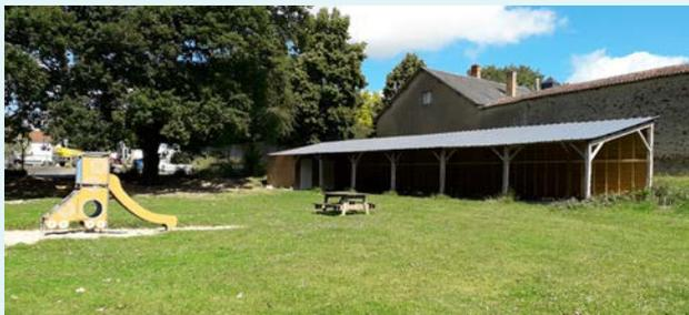
Chacun a pu remarquer que le préau de cet espace a été refait à neuf ! Après l'avoir démonté pour qu'il ne reste que sa charpente et sa dalle béton, il a fallu d'abord renforcer en quelques points son ossature, puis changer son bardage et sa toiture.
